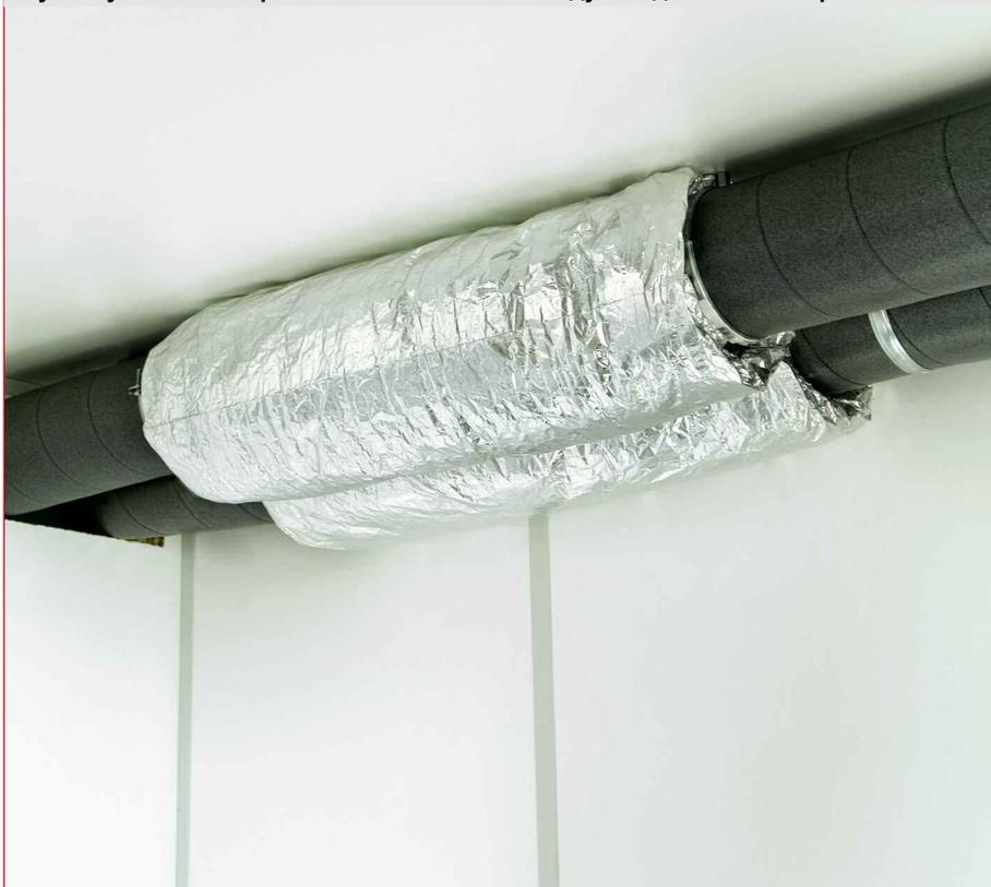
вать таким образом, чтобы он обеспечивал соблюдение требуемых граничных значений либо стандартов DIN 4109 A1 (2002-01). И здесь периферийное оборудование KWL выгодно отличается от классических витых труб: трубопроводящая система IsoPipe, звукопоглощающие распределительные коробки Helios FlexPipe, а также концепция прокладки трубопроводов в виде
