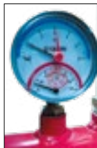
Термоманометр на выходе котла
