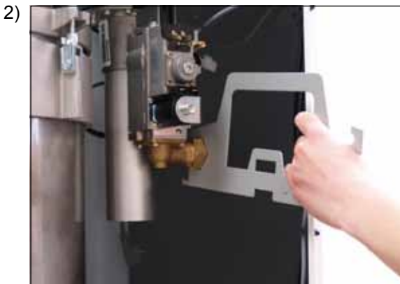
Verschraubung Gasanschluss am Gaskombiventil lösen
