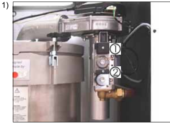
Wyjąć ①② wtyczkę (uprzędnio poluzować wkręty z rowkiem krzyżowym)
