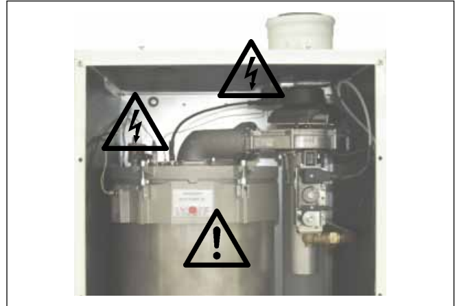
Billede: Tændingstransformer, tændelegte, varmeveksler Fare pga. elektrisk spænding, Fare for forbrænding på grund af varme komponenter
