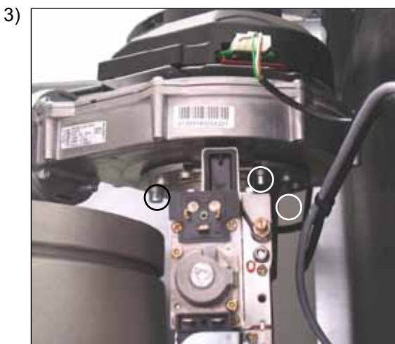
Desenroscar la cámara de mezcla del ventilador (3 tornillos Allen de 5 mm) y sacar el tubo de aspiración de aire si es necesario
