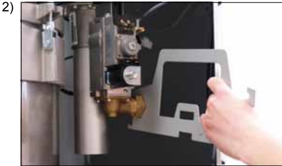
Løsn gastilslutning ved gasarmaturet
