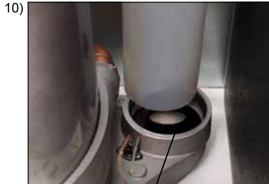
Дроссельная заслонка в дымовой трубе
