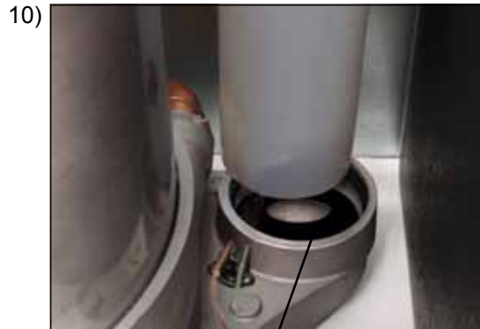
Διάφραγμα στραγγαλισμού καυσαερίων
