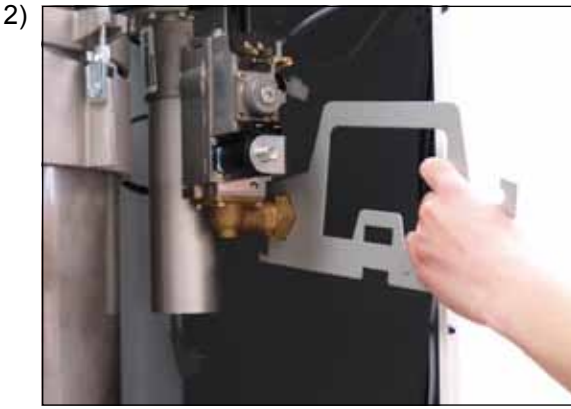
Gaz bağlantısının cıvatalarını gazlı kombi valfinden çözün
