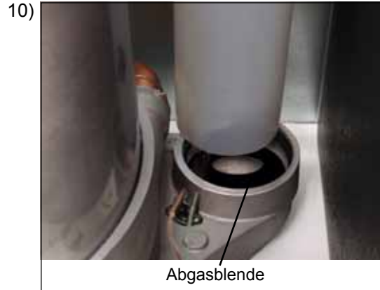
10) Abgasblende Ø 53 mm in die Kondensatwanne einlegen und Abgasrohr wieder hineinschieben.
