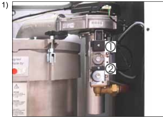
Stecker ①② abziehen (vorher Kreuzschlitzschrauben lösen)
