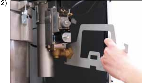
Gaz bağlantısının cıvatalarını gazlı kombi valfinden çözün
