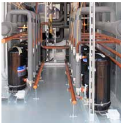
Встроенный компрессорно-конденсаторный блок
