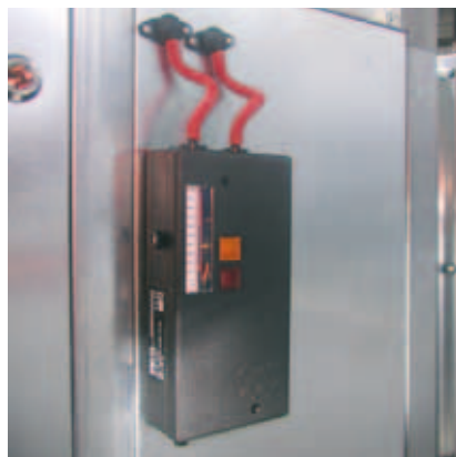
Манометр перепада давления (контроль фильтра)
