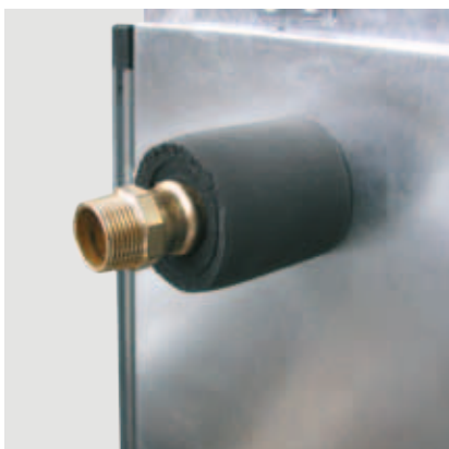
Проход сквозь панели с изоляцией Armaflex
