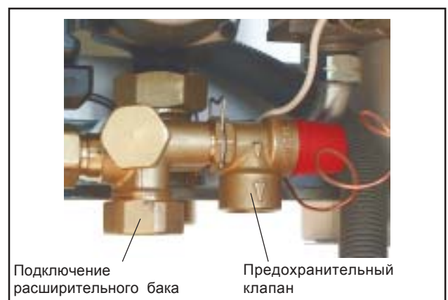
Рис.: Предохранительный клапан, подключение расширительного бака
